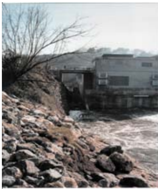
Foto7.16: Centrale con passaggio per pesci
