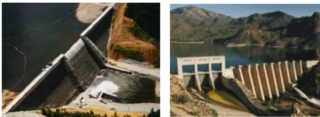
Foto 5.1: Esempi di diga a gravità (RCC) e di diga a contrafforti
