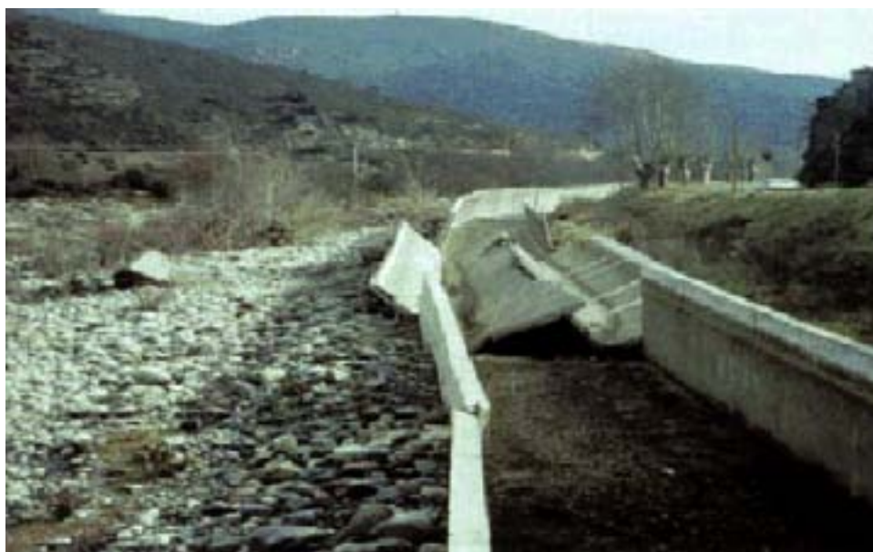
Foto 4-12 Il canale distrutto per effetto delle sottopressioni
