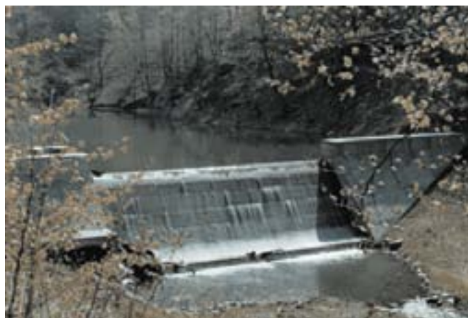
Foto 5.4 Traversa con profilo di Creager
