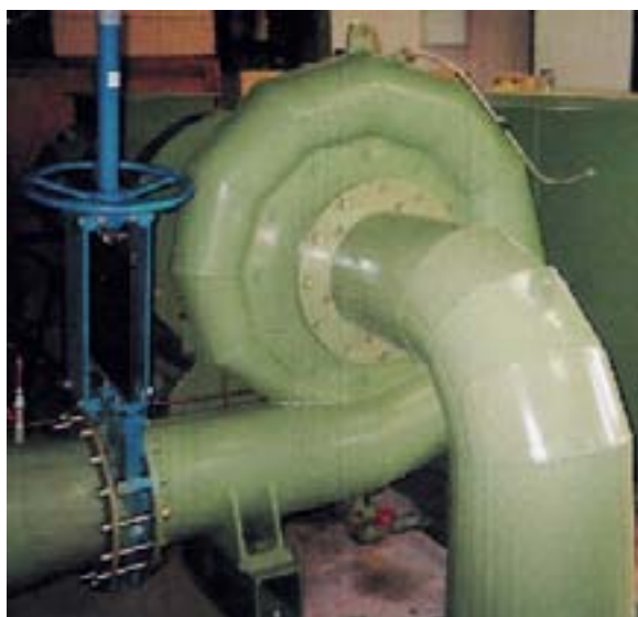
Foto 6.3: Turbina Francis ad asse orizzontale
