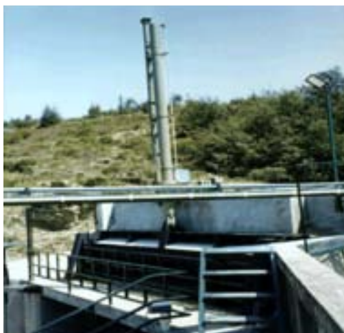
Foto 5.12: cilindro oleodinamico
