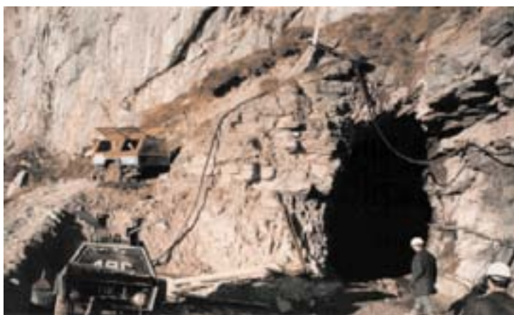
Foto 7.8: l'entrata del tunnel durante la costruzione
