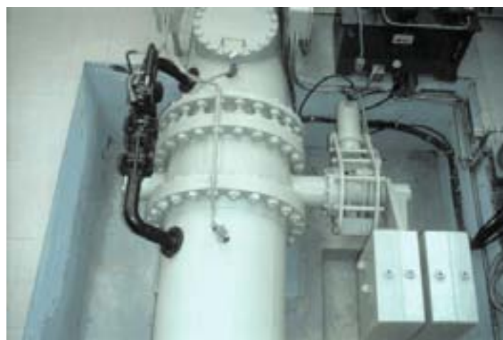
Foto 5.14: valvola a farfalla comandata oleodinamicamente
