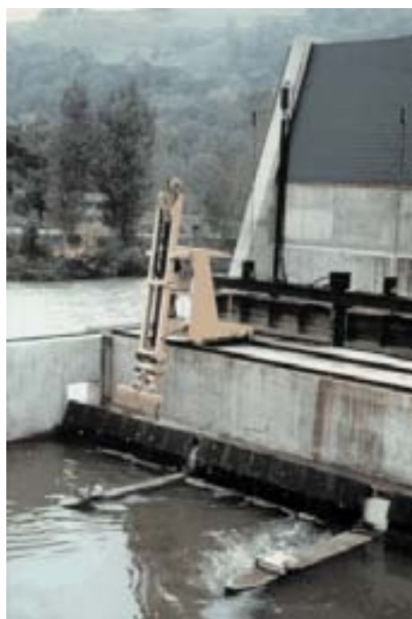
Foto 5.10: Cilindri oleodinamici telescopici
