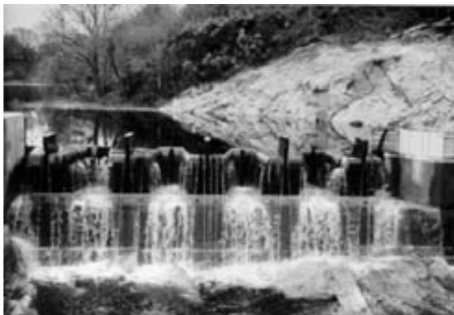
Foto 5.7: Fusegates della Hydroplus
