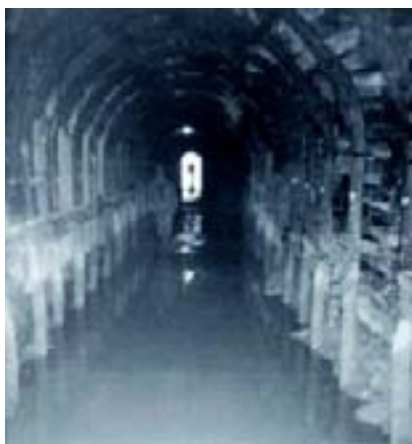
Foto 4.5: Vista dei lavori di costruzione della galleria
