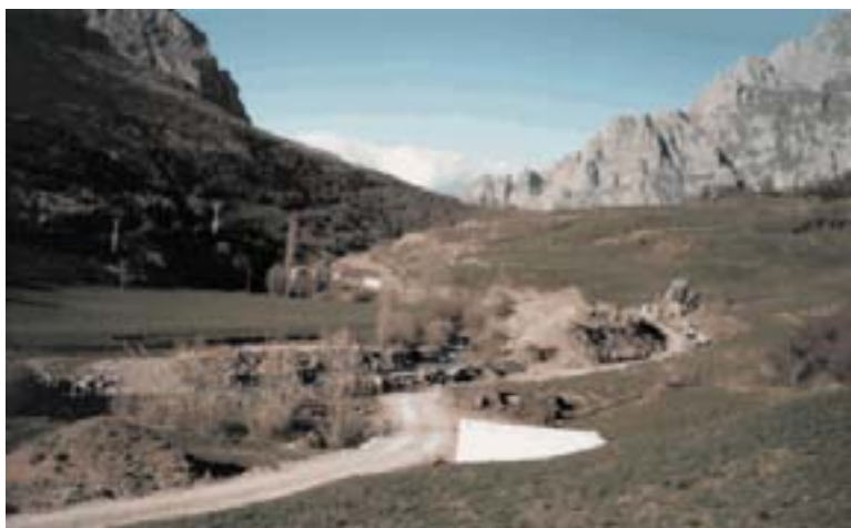
Foto 7.5: Fase di costruzione – scavo
