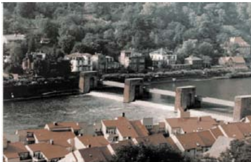
Foto 7. 12: Impianto di Neckar
