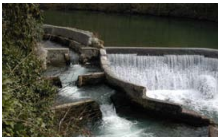
Foto 7.13: Passaggio per pesci di costruzione rustica
